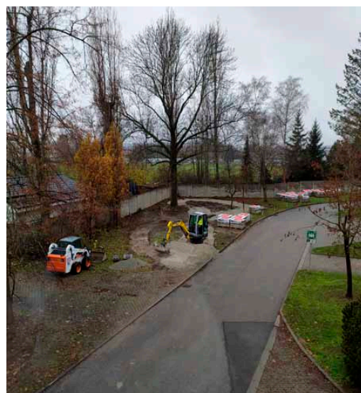
Průběh stavebních prací
