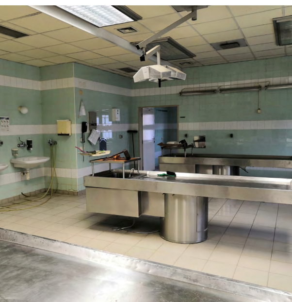
Staré prostory pitevní před rekonstrukcí
