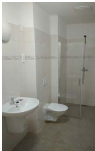
Koupelna v bytě nad lékárnou
