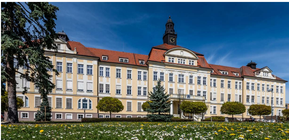
Nově zrekonstruovaná historická budova pavilonu A (Psychiatrické oddělení), fasáda získala ocenění Fasáda roku | Foto: Nemocnice České Budějovice, a.s.
