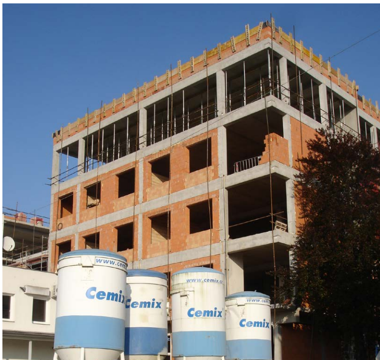
Výstavba perinatologického centra, říjen 2014 Foto: Nemocnice České Budějovice, a.s.
