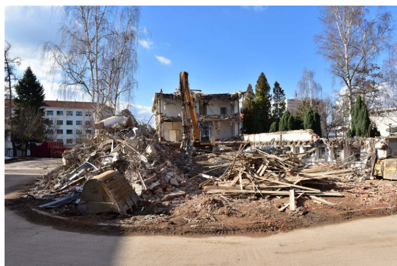
Původní pavilon Transfúzní stanice ustupuje výstavbě nového parkoviště pro veřejnost a zaměstnance | Foto: Nemocnice České Budějovice, a.s.
