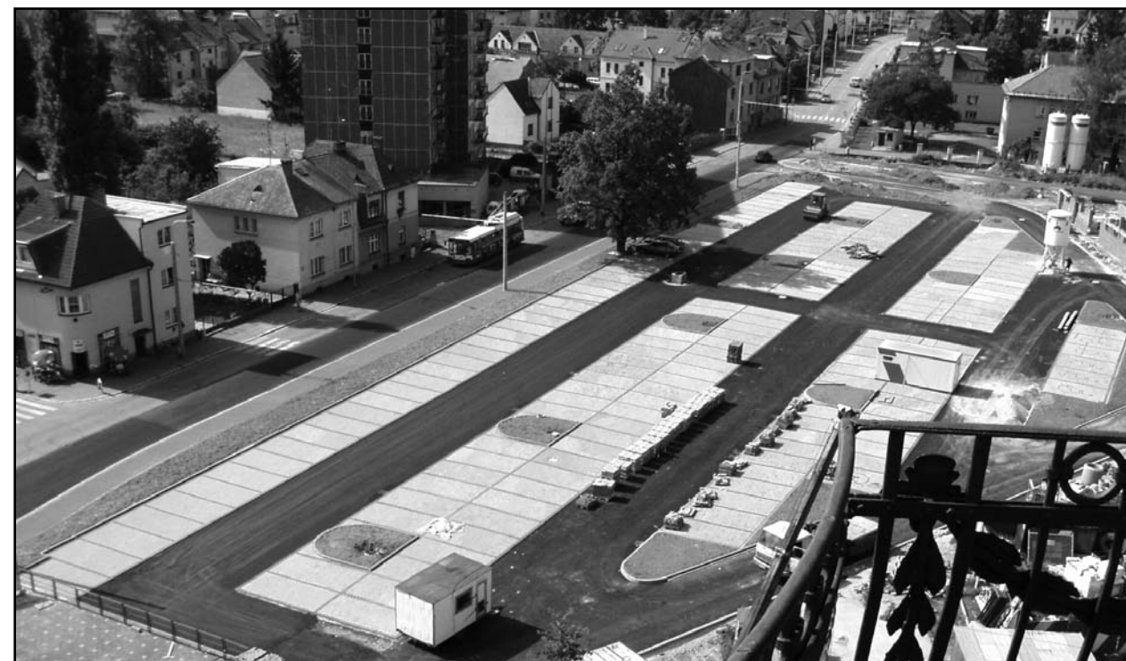
Stavba parkoviště vstupního terminálu – horní areál
